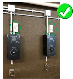
充電設施插座的上游位置應安裝斷流器 (開關掣),以便在插上充電連接器後 開啟電源,以及在拔出充電連接器前關 上電源。
