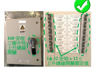
除有負荷控制的電路外,參差額不得應 用於供電予多個電動車的專用配電電 路。
