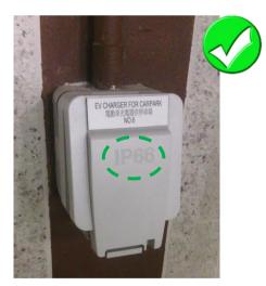
供室內停車場使用的電動車輛供電設備和插座及相關電力器具,均須加以適當防護以防止塵埃和水進入,有關的防護程度應達至IPX3。在室外安裝及使用的電動車輛充電設施,則無論是在插頭已插上或並無插上的情況下,防護程度都應達至IPX4或以上。
