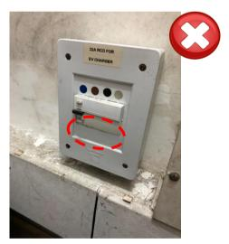
電流式漏電斷路器所在處或其附近未有提供進行測試的告示。
