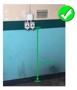
電動車輛供電設備或插座一般應安裝在 距離竣工地台水平約1.2米高的位置,以 便易於接觸。
