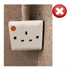
不可採用沒有適當防護的電動車輛供電設備和插座及相關電力器具。
