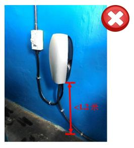
電動車輛供電設備或插座一般不應安裝在距離竣工地台水平1.2米高以下的位置。
